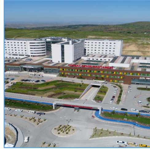
Yozgat Şehir Hastanesi
